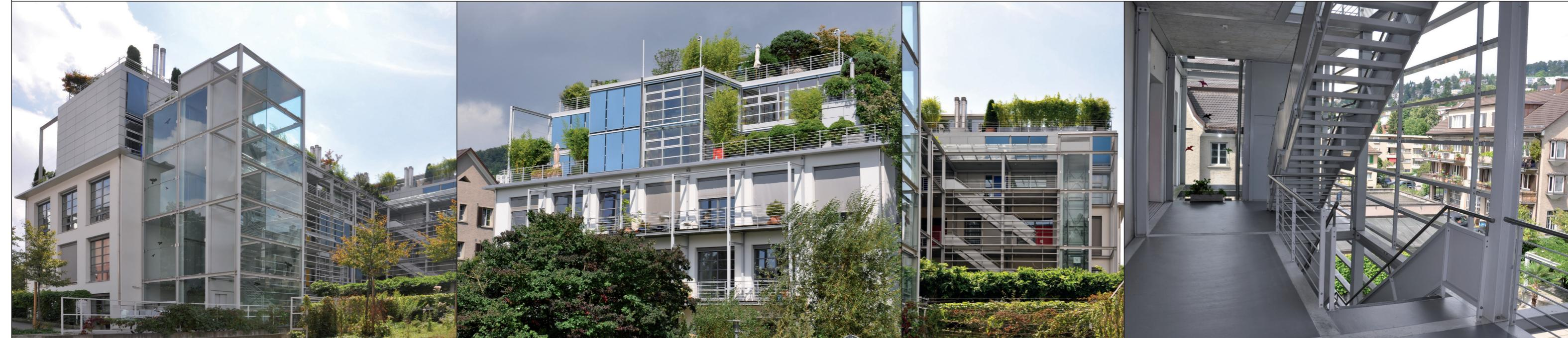
Nachdem das frühere Industriegebäude in faszinierende Loft-Wohnräume umgestaltet worden war, zeigten sich bald Mängel in der Bauausführung. Vor allem die aufgestockten Dachgeschosse brachten Probleme mit eindringendem Regenwasser. So wurde die Caretta + Gitz AG mit einer Totalsanierung beauftragt.
